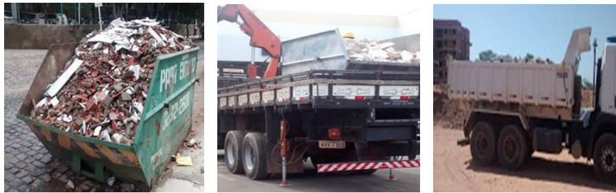
FIGURA 2: Etapas da coleta de resíduos nas construções civis da cidade de Teresina. FONTE: Autoria própria (2016).
