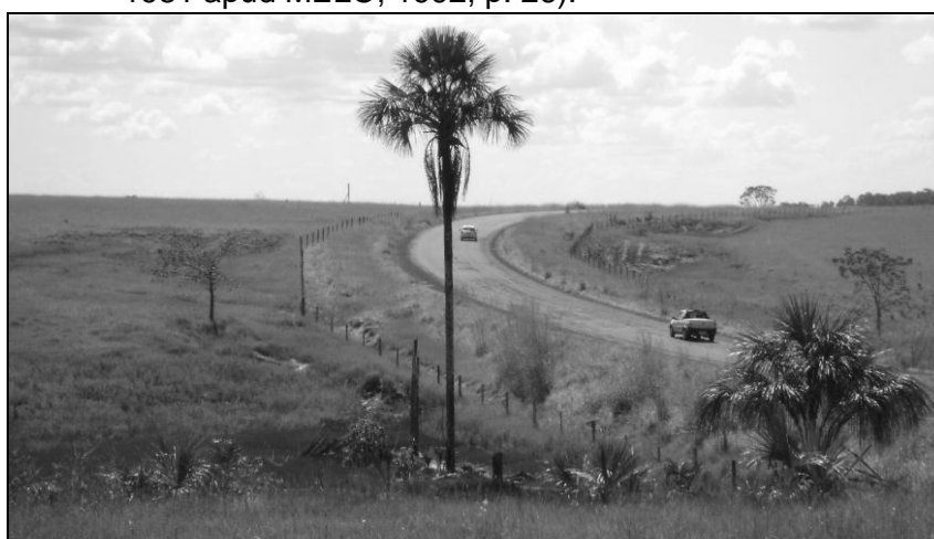
Figura 2 - Represamento de Vereda por aterro de rodovia - GO 210, município de Corumbaíba (GO). Autor: SANTOS, E. V. dos. (2013).
