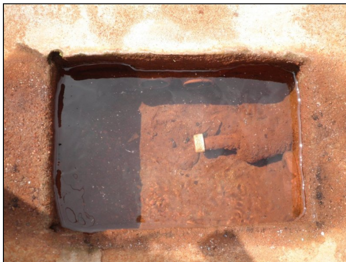
Figura 2: Caixa de inspeção presente na residência da propriedade que está a nascente do Bebedouro.
